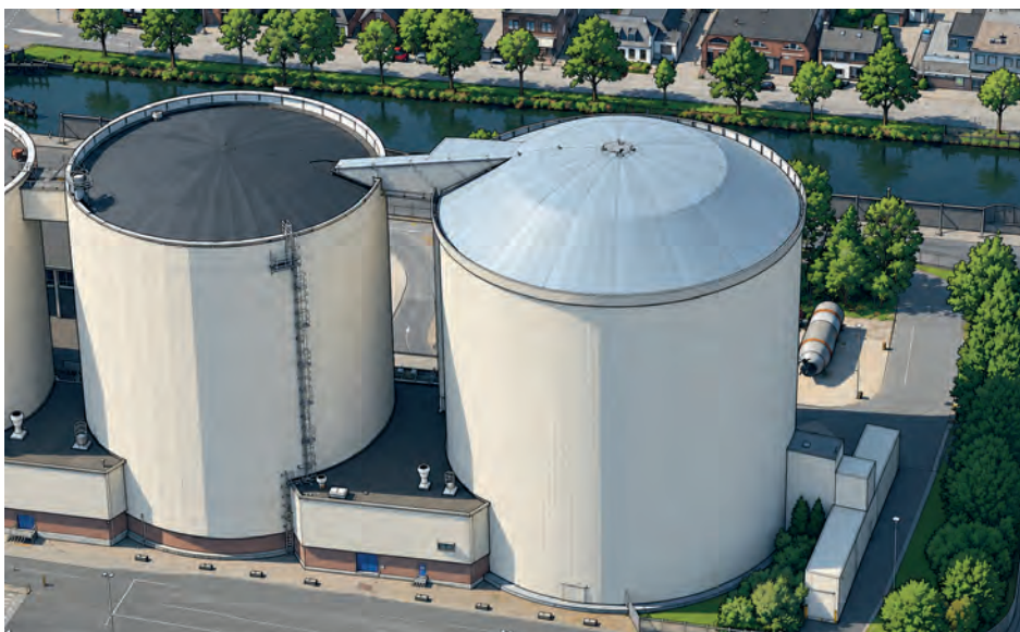
Het leegruimen van een suikersilo lijkt routine, totdat de gebruikelijke oplossing niet meer werkt. Eén afwijkende silo dwong Cosun Beet Company opnieuw naar de risico's en ATEX-maatregelen te kijken.
